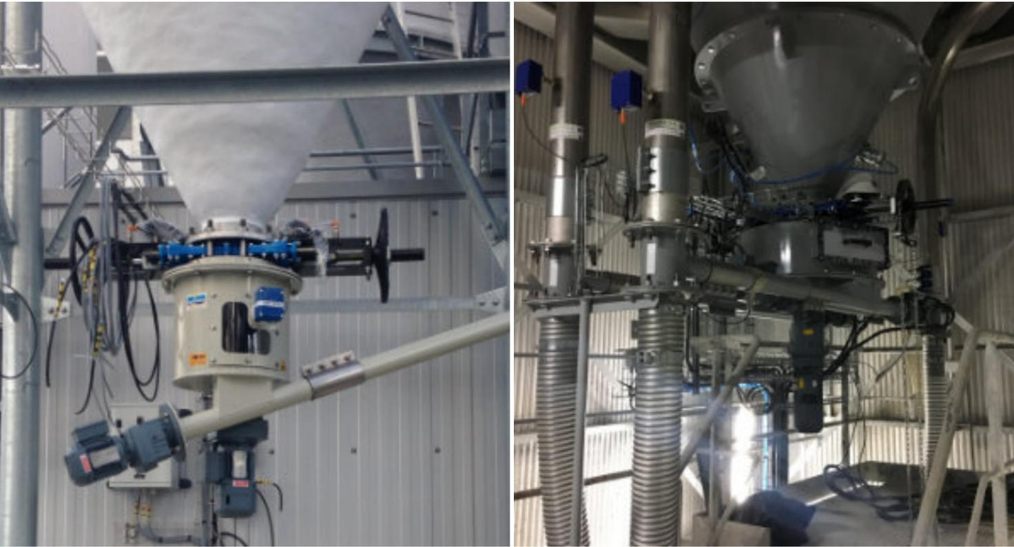
Das Austrags- und Dosiergerät ZFP 400 basiert auf derselben Funktionsweise wie die Silo Austrags- und Dosiergeräte, es lässt sich unter Behälter mittlerer Volumina (50 bis 5.000 Liter) einbauen. Beim ZFP 400 können bis zu 2, beim ZFP 800 bis zu 4 Dosierschnecken unter einem Behälter angebracht werden.
